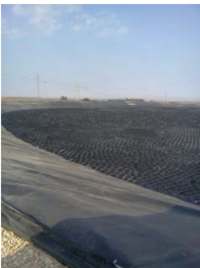
Imagen: Depósito de agua de 3500 m 2
